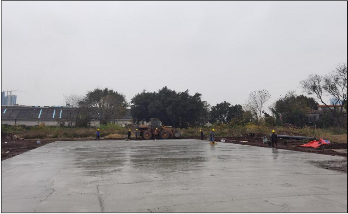
图 3.5-9 污染土待检区防渗结构建设
