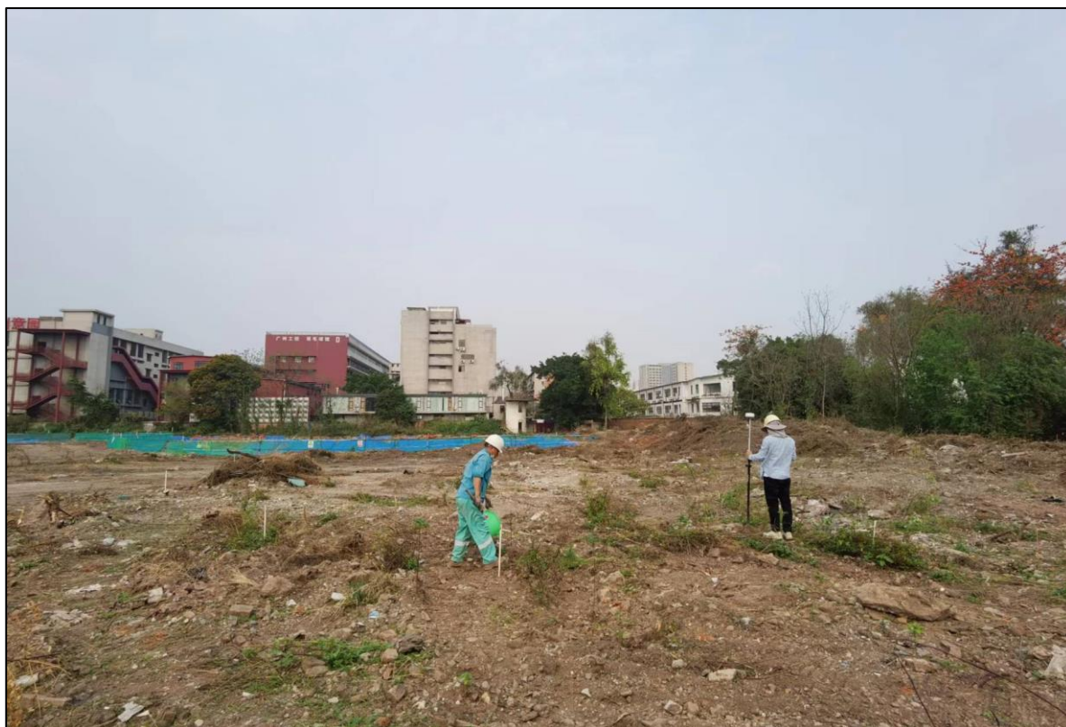
图 3.5-3 基坑现场坑顶拐点范围划线
