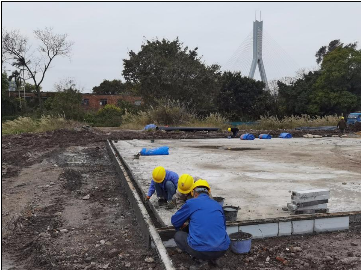
图 3.5-10 污染土待检区排水沟及围堰
