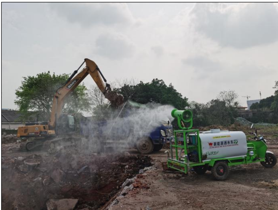
图 3.5-5 基坑污染土壤清挖
